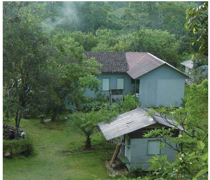
Casona del Dr. Skutch, inmersa en la vegetación de Los Cusingos. Nótese el techo del estudio (al fondo, a la derecha) desde donde produjo su vasta obra científica (Foto: Enrique Ramírez Guier).
